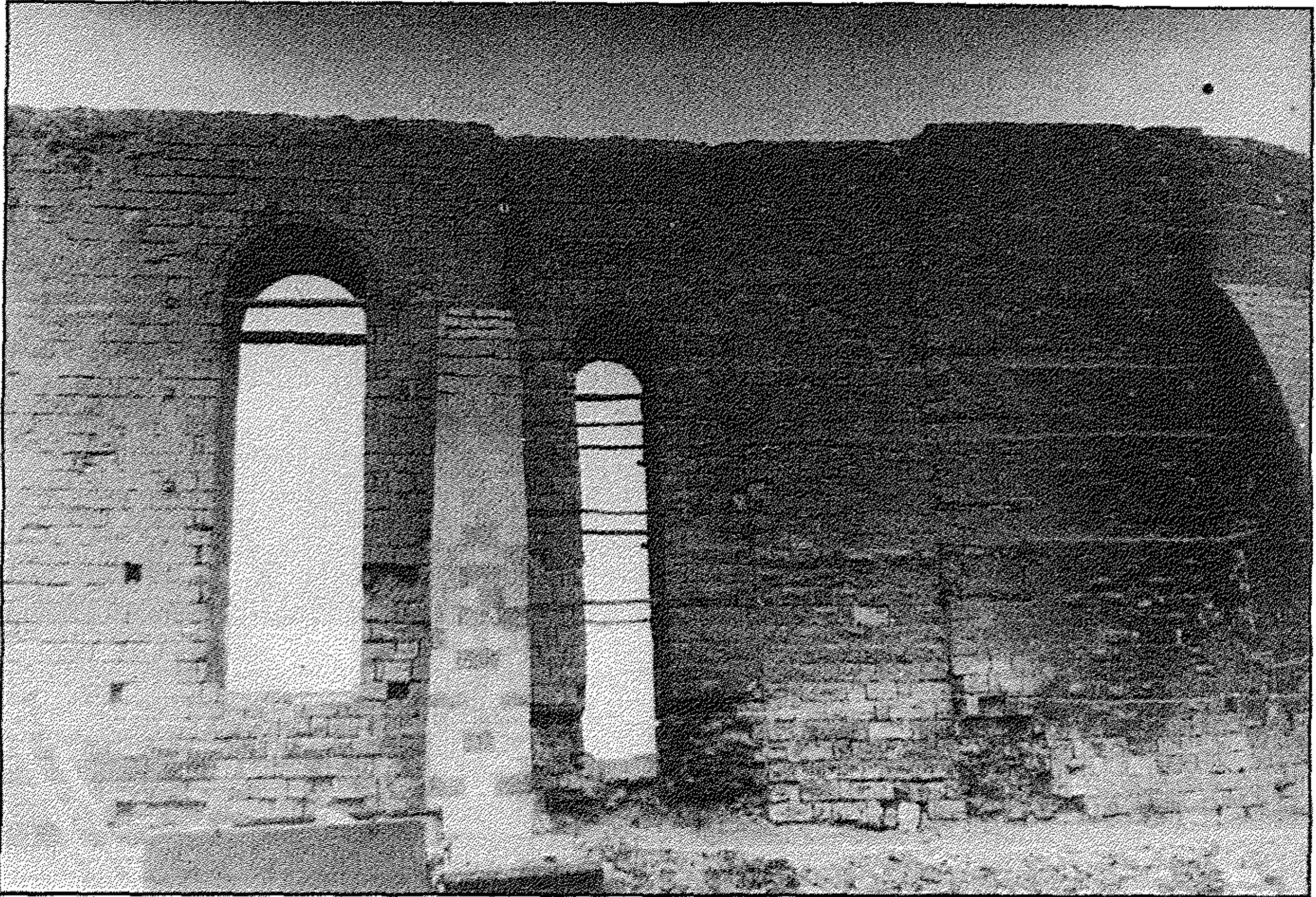
42 - قناطر المياه (سور مجرى العيون) - جزء من القناطر بعد ترميمه
